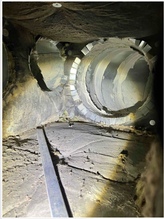
Inside return plenum
